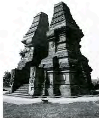
写-14 「ウリンギン・ラワン」割れ門
